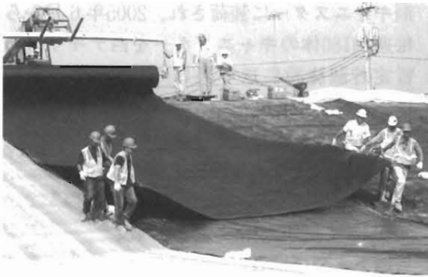
写真1 オンサイト処分場建設現場
