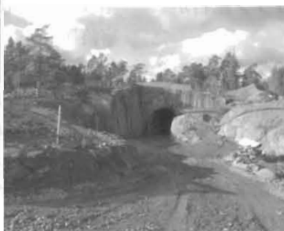
図4 オンカロ施設の斜坑入口建設現場
