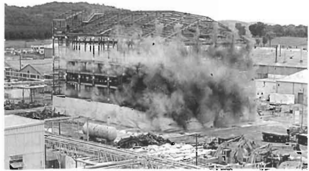
写真2 Plant - 4の建屋解体
